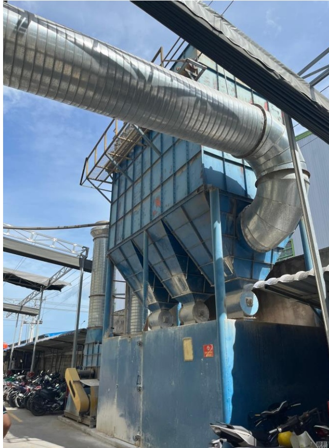
Hình 3. 6. Hình ảnh minh họa hệ thống lọc bụi túi vải
