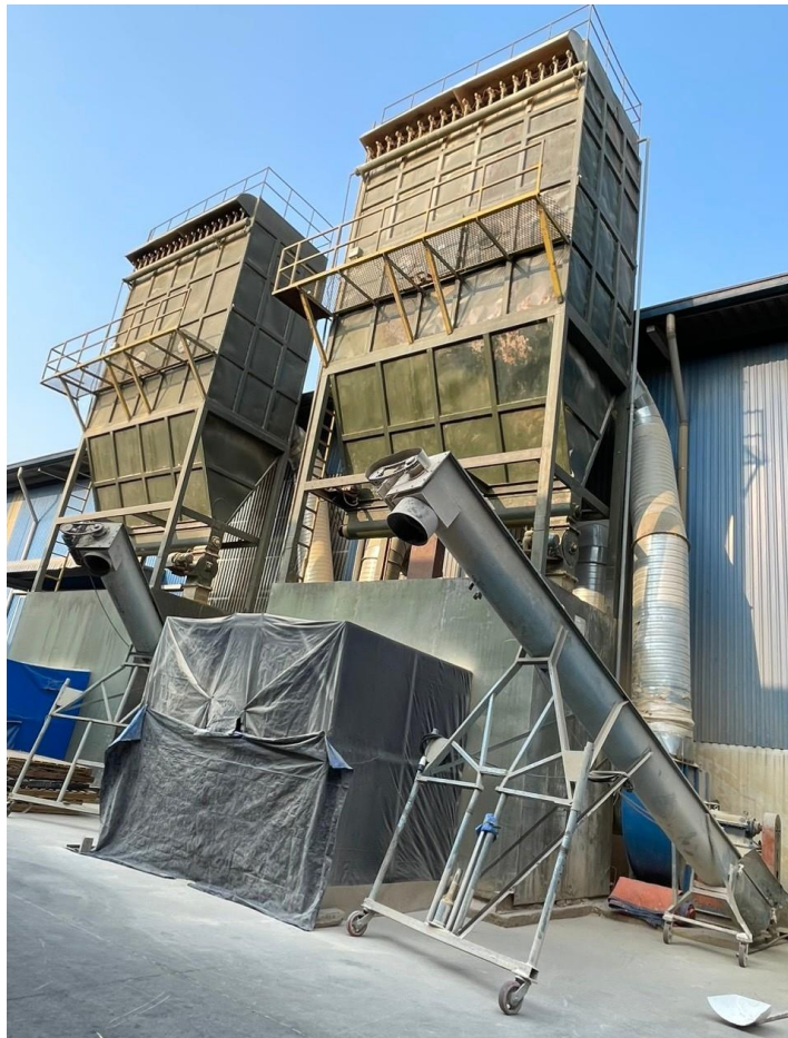
Hình 3.7. Hình ảnh hệ thống xử lý bụi
